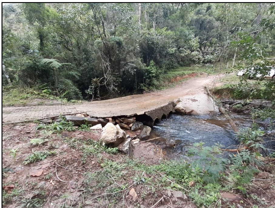
Figura 13 - Foto da travessia 6.
